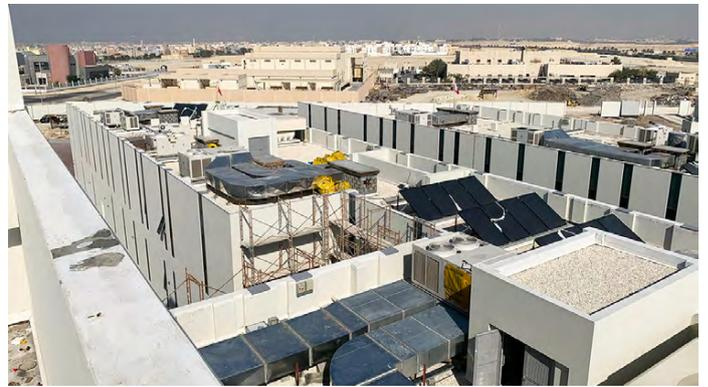
وتضمّن نطاق العمل توريد 17 وحدة تكييف مدمجة مركزية عالية الكفاءة، و 28 وحدة مناولة الهواء، و 12 وحدة مناولة الهواء مزدوجة الجدران، ووحدات مجزأة مركزية مع وحدات ملف التبريد والمروحة المخفية، وفحصها وتشغيلها في المجمّع. وستوفر هذه الأجهزة قدرة تبريد إجمالية تصل إلى 600 طن تبريد لمختلف المباني والمرافق في المجمّع.
